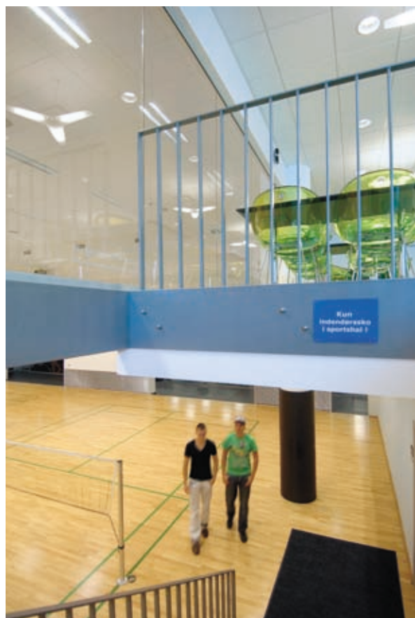
Sportshal med café. Loftsarmaturerne i hallen er lystofrørsarmaturer Miral med 2x54 W lysstofrør. Lyset i caféen kommer fra dekorative Airco pendler med 3x24 W lysstofrør. Foto: Torben Petersen.
